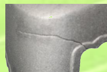
ひび割れ生地不良
